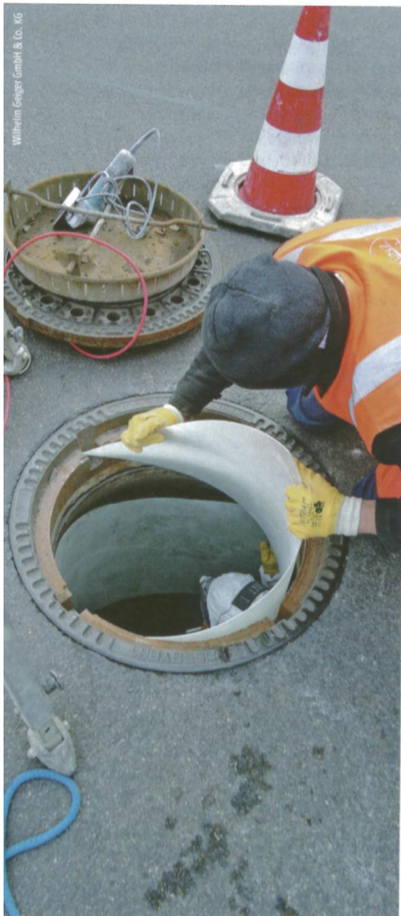
Die Schachtbauwerke wurden mit GFK-Platten gegen chemische Belastungen geschützt.
