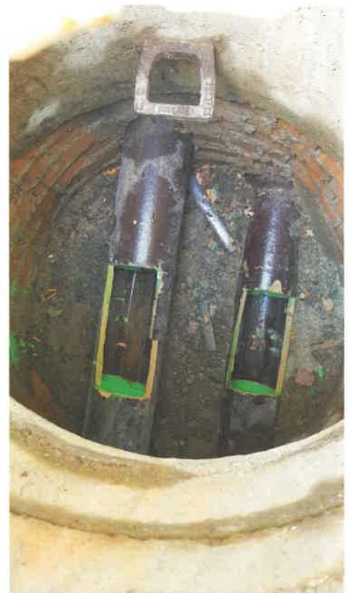
Bild 2: Blick in den Schacht mit den Hausanschlussleitungen
